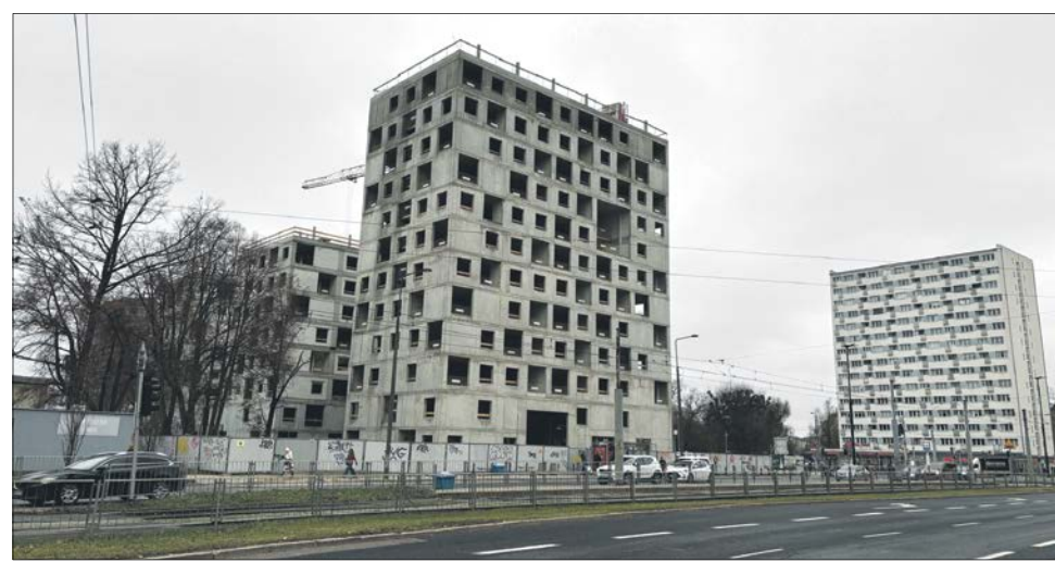
Rozproszona zabudowa generuje koszty w postaci konieczności doprowadzenia kanalizacji i wodociągów oraz budowy dodatkowych dróg.
