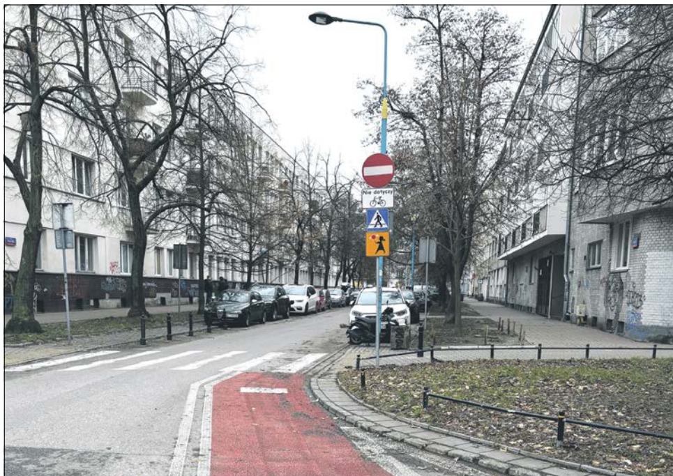
W ramach 20 odcinków DDR na terenie Warszawy wybudowano i przebudowano już ok. 7 km tras rowerowych w różnych częściach miasta.
