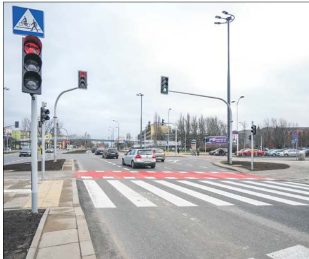
Nowe przejście dla pieszych przez ul. Ostrobramską dołączyło do blisko 100 innych wybudowanych w ostatnich latach.
